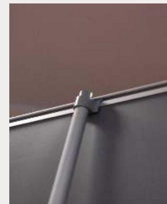
Mocowanie listwy zaciskowej na słupku pionowym.
